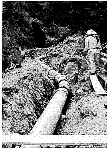
写真-2 水圧管路布設状況
